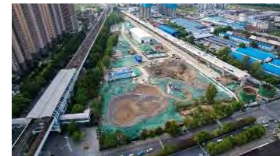
南泥湾大道南侧地块修复
