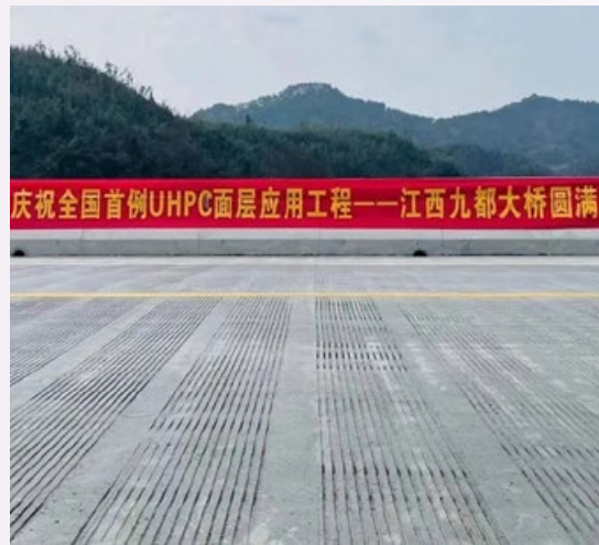
超可隆应用于江西上饶德兴市九都大桥危桥重建工程项目
