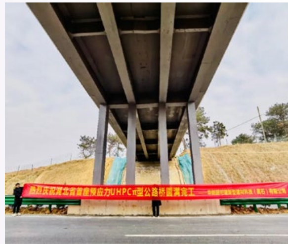
超可隆应用于麻安高速全预制拼装 UHPC 跨线桥项目
